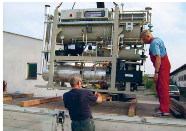
Szenen von der Montage der Klein-Absorptionskälteanlage und nach Montageende
