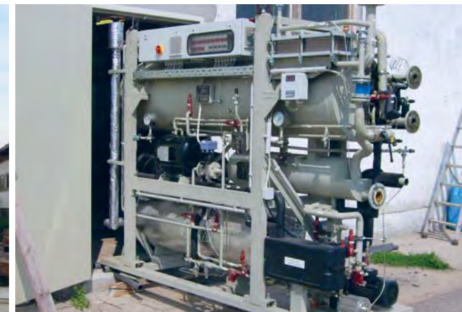
Szenen von der Montage der Klein-Absorptionskälteanlage und nach Montageende
