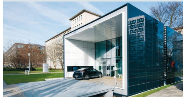
Dieses Effizienzhaus Plus erzeugt innerhalb eines Jahres mehr Energie, als eine vierköpfige Familie für den Betrieb des Hauses benötigt; Quelle: ZEBAU
