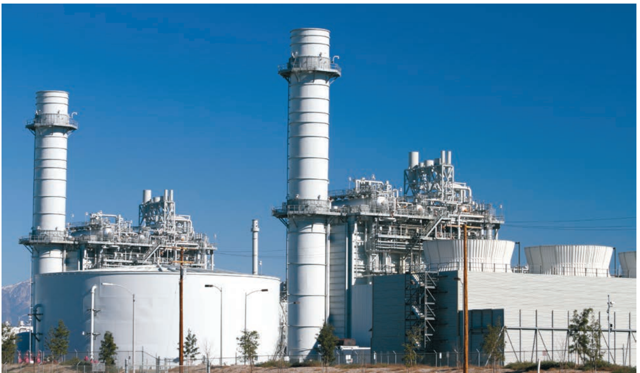
Gasturbinenkraftwerk, Quelle: Stock photo © AvailableLight
