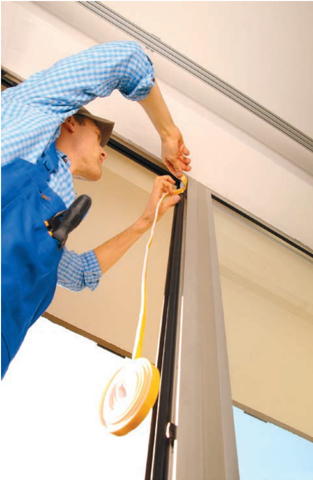
Auch kleine Maßnahmen wie die Abdichtung von Fenstern sparen Energie, Quelle: fotolia © RioPatuca Images
