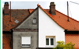
Wärmedämmung - links ohne, rechts mit | © spiber / shutterstock.com
