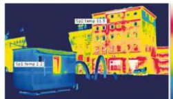
Die Thermografie Aufnahme des modernen Posthauses (links). Am Ansatz von dem Forum Allgäu in Komplexen steht, zeigt deutlich, dass dieses kleine Gebäude dank der sehr guten Wärmedämmung wesentlich weniger Wärme verliert als die umliegenden Gebäude. Rote und gelbe Teile weisen auf einen hohen Wärmeverlust hin, grüne und blaue Farben auf einen niedrigen.
